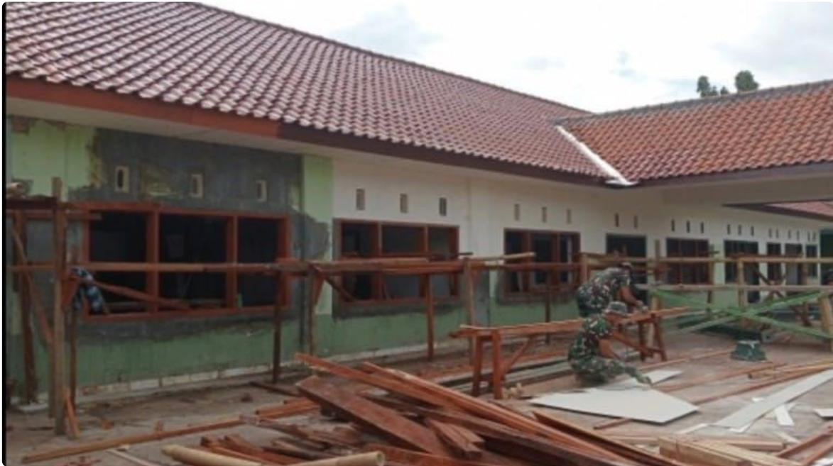
Sasaran pengerjaan memasuki finishing bagian luar, baik kusen maupun risplang , bagian dalam pemasangan plafon dan keramik dan pengecatan dinding. Sesuai pemantauan kami di lokasi pada Selasa 12/03/2024.
